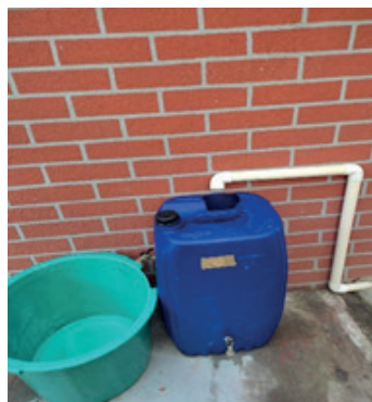
Figura 10. Almacenamiento de agua de la recolección pluvial.
